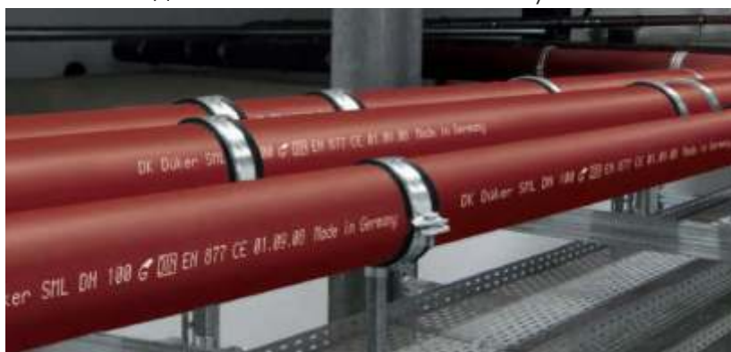
Рис. 15. Безрозтрубні чавунні каналізаційні SML труби
